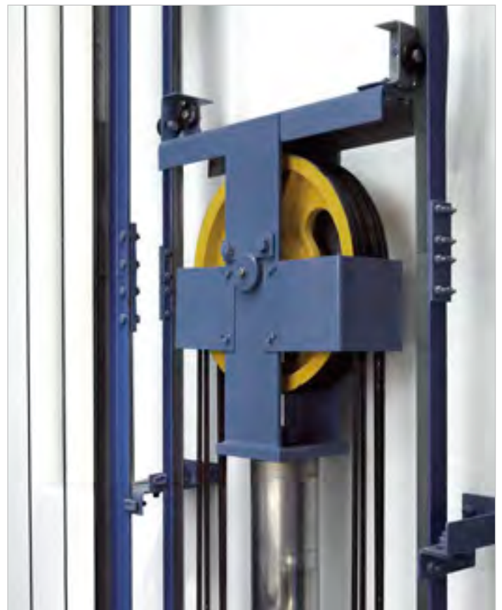
Hydraulikkolben mit Umlenkrolle
